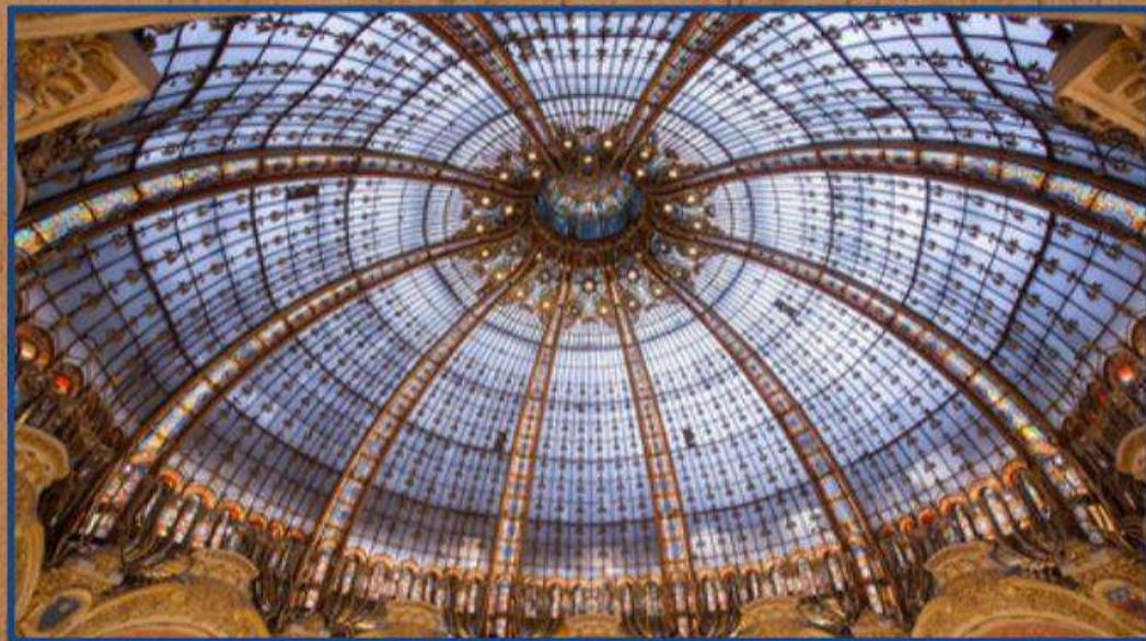
Il soffitto del negozio è una copertura voltata in ferro e vetro che ripercorre la stessa forma ellittica della pianta del negozio.
